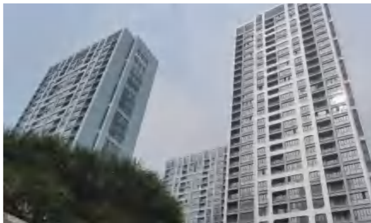
» 悉奥涂料—山东泰安·中泰御湖湾
